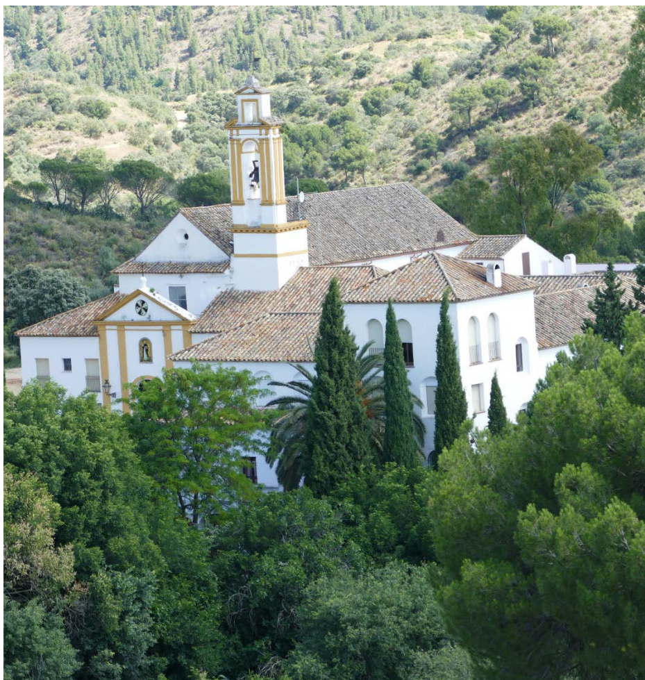
Vista exterior del convento de Scala Coeli (foto Carlos Romero Mensaque)
