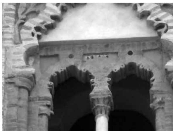
Figura 4. Iglesia de San Marcos. Ventana lado oeste (detalle)
