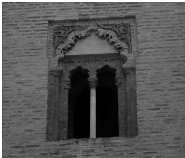
Figura 3. Iglesia de San Marcos. Ventana lado oeste
