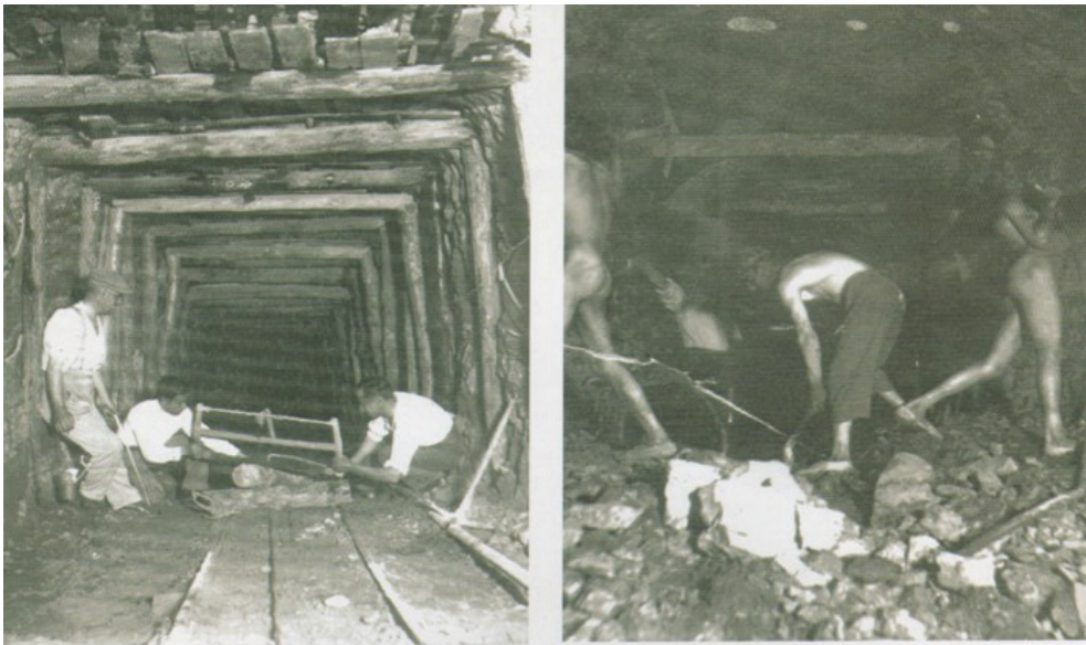
Curiosas imágenes de trabajos en el interior de la mina; en la primera se puede observar labores de entibación, y en la segunda como se llegaban a realizar trabajos totalmente desnudos debido a las condiciones extremas de las galerías.
