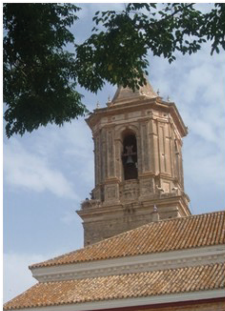
Figura 5D etalle del campanario de la torre.
