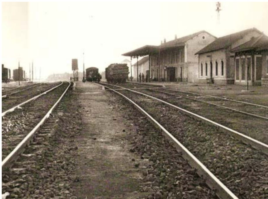
Estación de La Roda de Andalucía. Fototeca municipal
