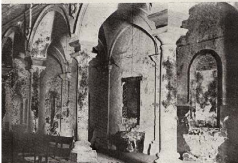
Fig. 97. Los Corrales. Parroquia de Santiago el Mayor. Interior después del saqueo
