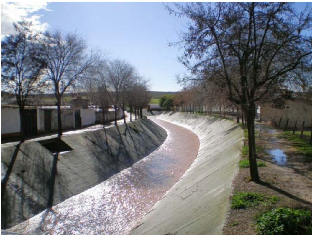
Encauzamiento y canalización del Río Yeguas realizado en 1975 en el casco urbano de La Roda.
