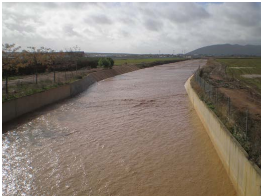
Encauzamiento y canalización del Río Salinoso en La Roda. 2002.
