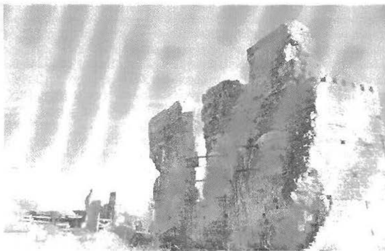
Paredones de la iglesia del convento de Aguas Santas.
